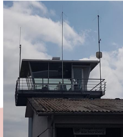
Bild: Funkanlage auf dem Wächtersberg
